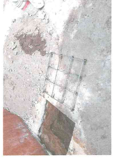
FOTO 4. ARMADO PARRILLA ZAPATA
