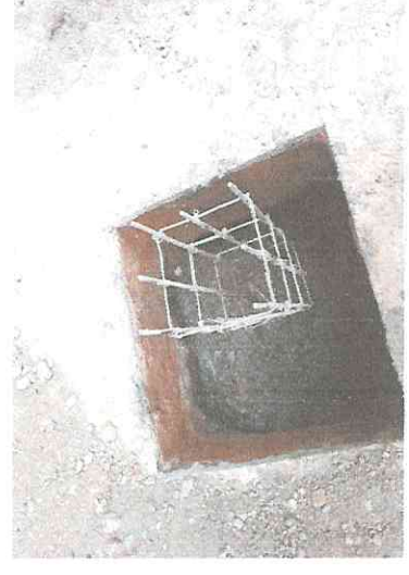
FOTO 5. ARMADO PARRILLA ZAPATA
