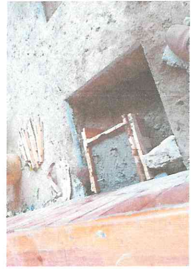
FOTO 6. ZAPATA AISLADA
