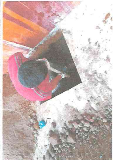
FOTO 1. EXCAVACIÓN PARA ZAPATAS
